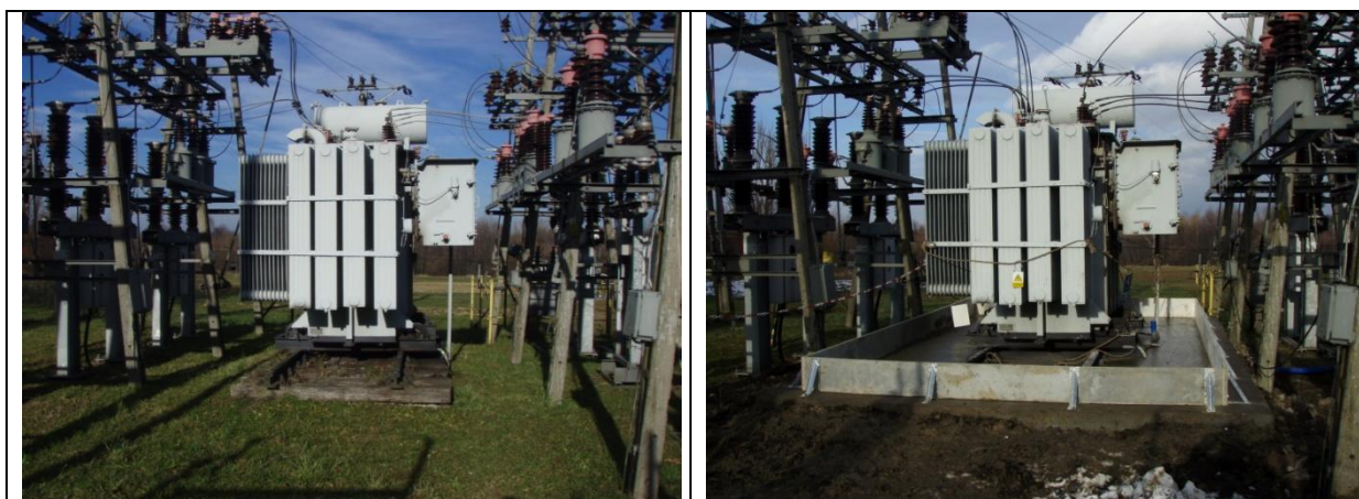
Widok przed i po montażu misy olejowej ReBund GRC
